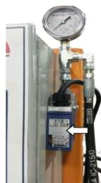
Si le détecteur de pression est défectueux, il est possible qu'il envoie un signal en permanence OU trop rapidement.
