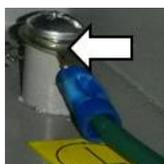
Activer le contacteur et vérifier si voltage est présent sur les trois phases d'alimentation du moteur. Avec un voltmètre en mode AC, connecter la sonde noire sur la vis de mise à la terre du panneau.
