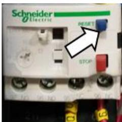
Laisser le moteur refroidir et appuyer sur le bouton bleu reset sur le côté droit du relais de surcharge.
